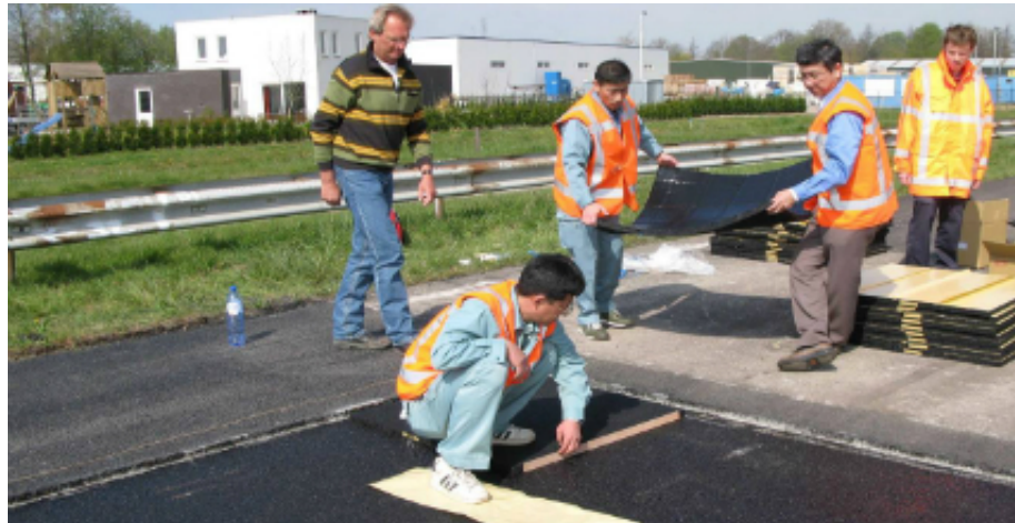
Proef met asfalttegels in Kloosterzande.
